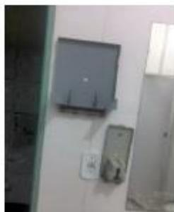
Porta-toalhas quebrados e sem papel, válvulas de descarga emperradas
