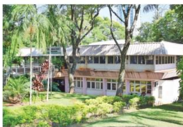
Prédio antigo da Câmara, inaugurado em 1972, vai centralizar atendimento aos empresários de Foz
