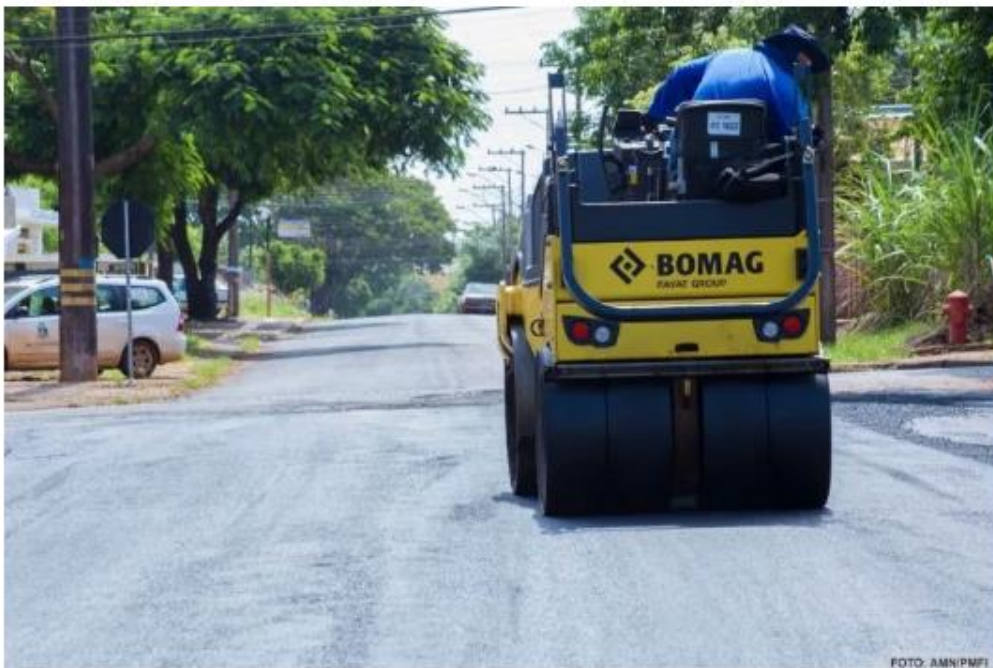
Maquinário asfalta a reeleição de Chico Brasileiro. Foto: PMFI
