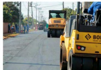
Nesta fase, oito vias serão contempladas com as melhorias executadas pelo programa de pavimentação da Prefeitura de Foz do Iguaçu
