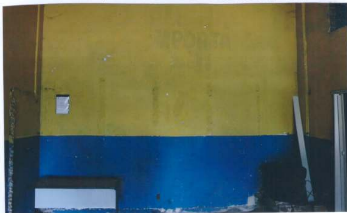
Foto 3: Estrutura da empresa E. J. DE MELO CONSTRUTORA – ME
