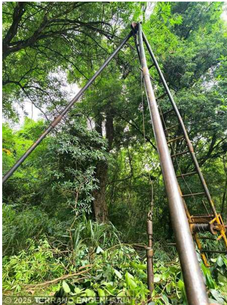
Imagem 07 – Sondagem de Solo (Terrano Engenharia)
